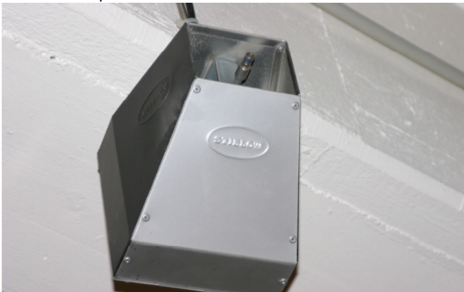
Befeuchterkopf mit Düse
